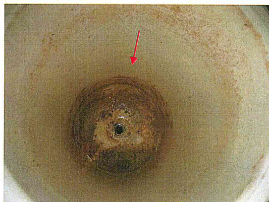
Foto 12 – alojamento do filtro do caminhão abastecedor
