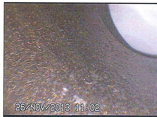
Foto 6 – câmara interna da FCU apresentando contaminação
