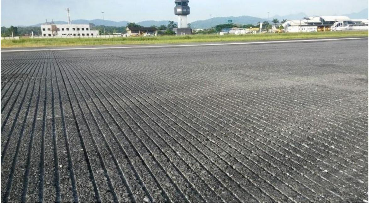
Figura 9 - Grooving na pista<sup>23</sup>
