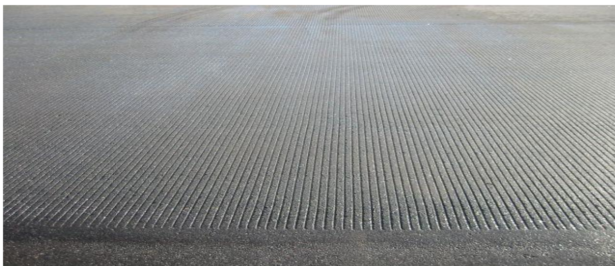
Ilustração 33 – Grooving em pavimento asfáltico
