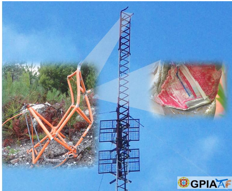
Figura 5 || Figure 5 Danos na torre de radiodifusão com detritos da pá do rotor principal || Radio broadcasting tower damage with main rotor debris attached
